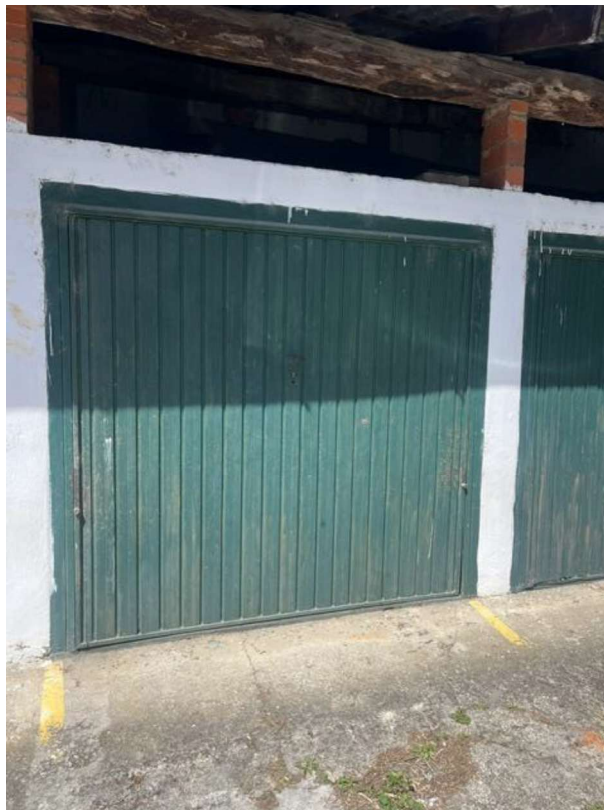
VISTA ESTERNA - AUTORIMESSA
